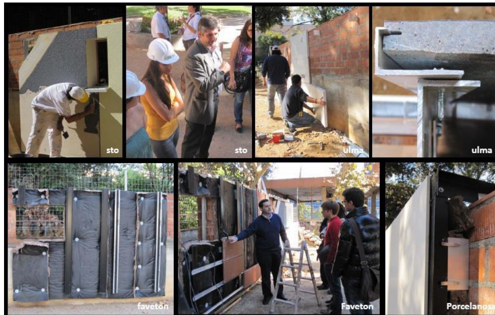
Figura 6. Puesta en obra de distintos sistemas constructivos de envolventes.
