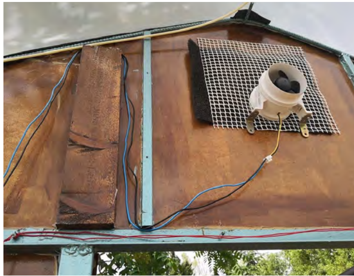
Imatges 3.2.3.5 - Connexió del extractor d'aire
