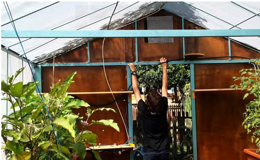
Imatge 3.2.3.2 - Alumne realitzant el cablejat de la instal·lació.
