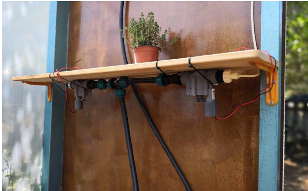
Imatge 3.2.4.4 - Disposició de les electrovàlvules.
