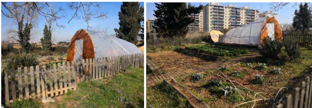
Imatges 1.2.1. i 1.2.2. - Estat inicial hivernacle. Estructura
