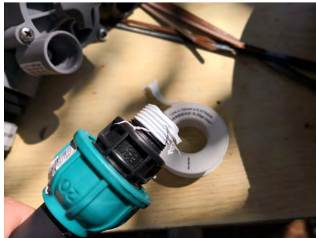
Imatge 3.2.4.4 - Reparació connexió amb la col·locació de cinta de tefló.
