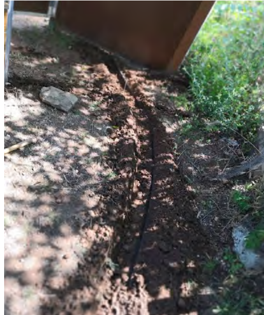
Imatge 3.2.4.3 - Rasa per a la presa d'aigua
