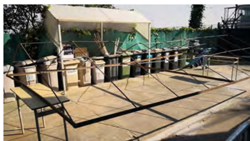
Imatges 1.2.3. - Nova estructura Hivernacle. Sostre
