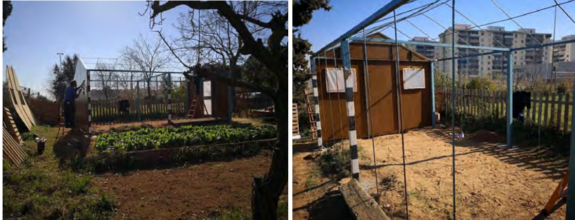
Imatges 1.2.4. i 1.2.5. - Nova estructura Hivernacle. Muntatge
