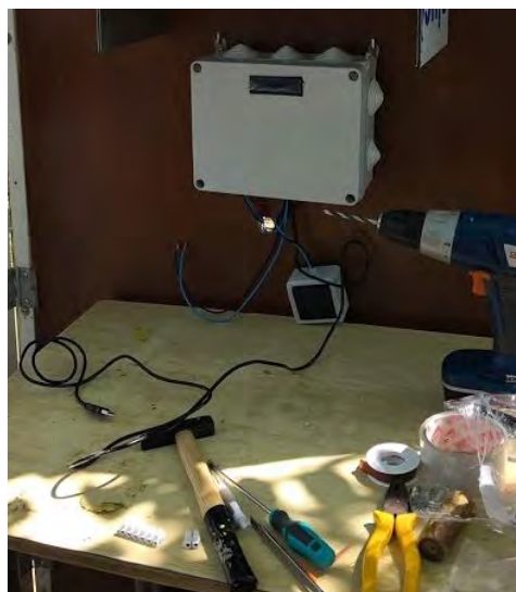
Imatge 3.2.3.5 - Connexions elctriques del quadre de control
