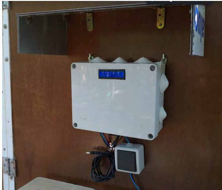
Imatge 3.2.3.6 - Prova elèctrica de l'instal·lació.
