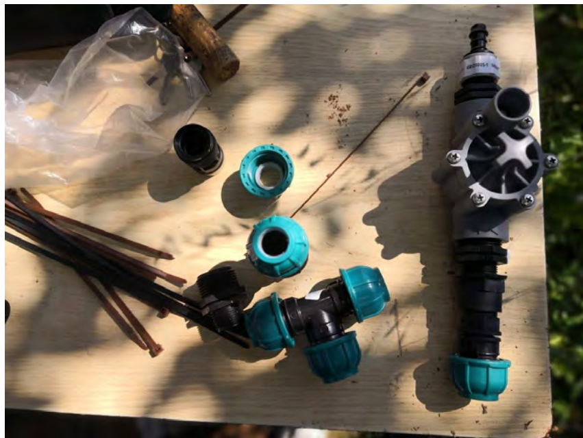
Imatge 3.2.4.2 - Preparació connexió electrovàlvules
