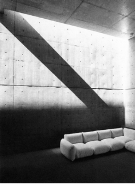
Fig. 13: Tadao Ando es capaz de conseguir una textura totalmente lisa con el hormigón armado
