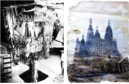
Fig. 19 y 20: Maqueta y vista invertida, forma y estructura dependían íntimamente la una de la otra. En ellas se aprecian las catenarias de arcos y bóvedas
