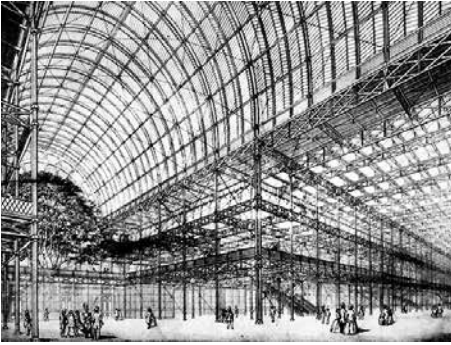
Fig. 1: Una de las estructuras más importantes de hierro colado
