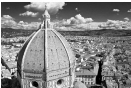
Fig. 8: Cúpula de doble pared con componentes tramados para obviar la necesidad de contrafuertes exteriores
