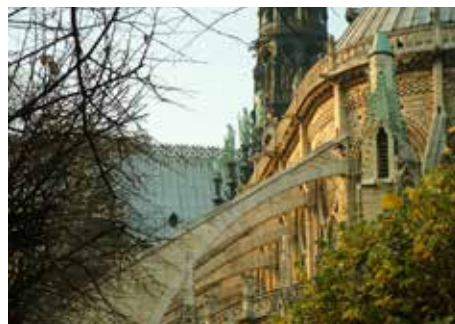
Fig. 5: El arbotante desmaterializa el muro
