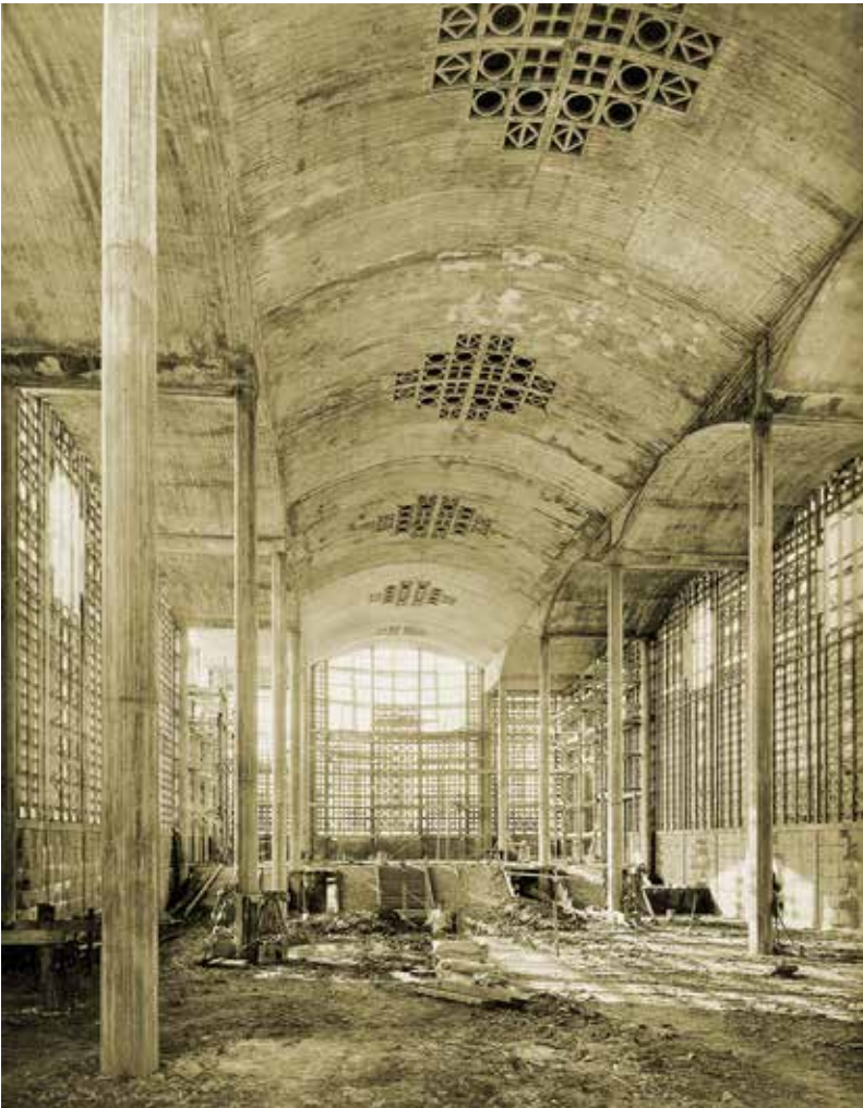
Fig. 23: La estructura de hormigón armado libera las fachadas expresando al mismo tiempo su esbeltez y liviandad en comparación con las catedrales anteriores. Al mismo tiempo una gran cantidad de iluminación natural inunda el espacio.
