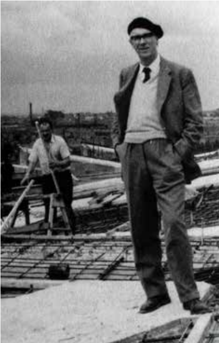
Fig. 4: Ove Arup durante la construcción de la Catedral de Coventry, donde trabajó como asesor
