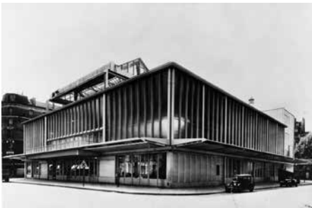
Fig. 34: La estructura de la planta superior se desmaterializa gracias a los elementos verticales para la fijación del vidrio
