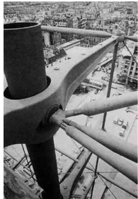
Fig. 2 y 3: La composición de la estructura depende de diferentes factores. En este caso se optó por utilizar fundición de acero, asociando la forma al diagrama estructural
