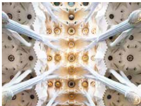
Fig. 7: Las columnas se ramifican como si de un árbol se tratase
