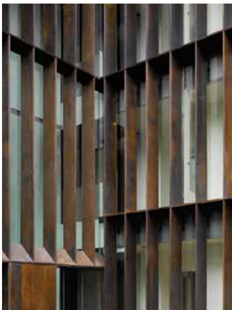
Fig. 3: El muro descompuesto supone un antes y un después en la evolución de los cerramientos
