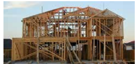
Fig. 6: La evolución de la tipología del Balloon Frame de madera dió lugar al Steel Frame
