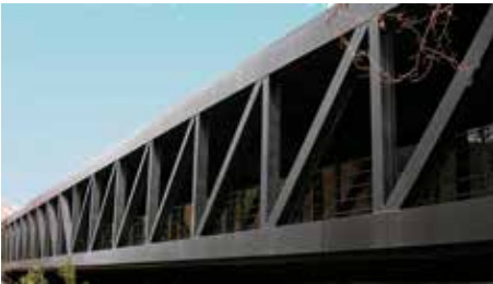
Fig. 3: Cuando las luces superan una determinada distancia es habitual el uso de cerchas
