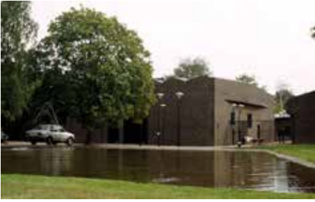
Fig. 40: Imagen exterior en la que se observan las bóvedas de cubierta
