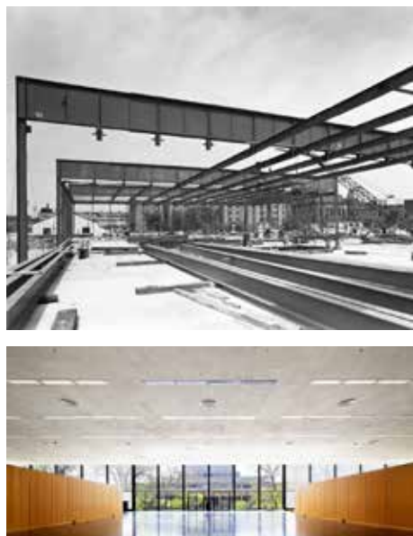
Fig. 12 y 13: Con las vigas de gran canto, en la parte superior de la cubierta, se libera el espacio interior sin que el esfuerzo se aprecie, pareciendo que lo que en realidad sustenta el edificio son los perfiles de fachada
