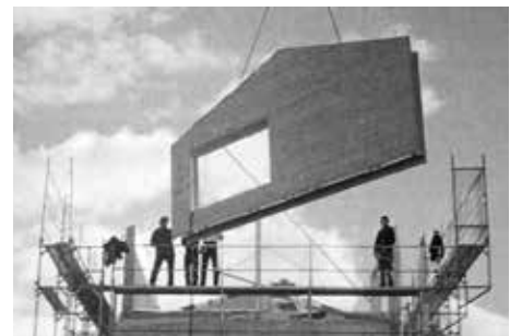
Fig. 16: Montaje de un sistema constructivo de paneles compactos de madera
