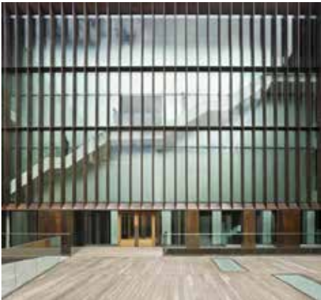
Fig. 3: El muro descompuestono se aprecia jerarquía estructural alguna, se lee como un cerramiento ligero y continuo
