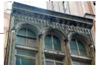
Fig. 12: Fachada metálica de Bogardus
