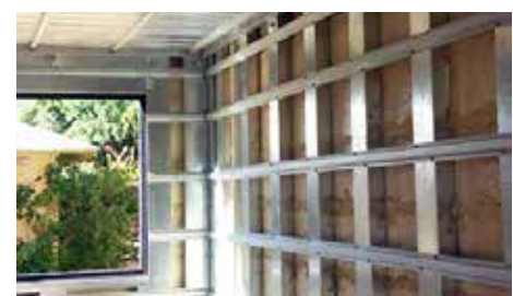
Fig. 7 y 8: La estructura está compuesta por perfiles de bajo espesor, los cuales no constituyen el cerramiento
