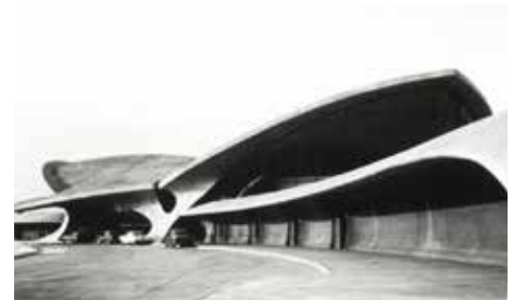
Fig. 38: Potente estructura de cubierta que otorga un papel principal a la estructura
