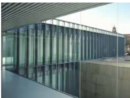
Fig. 14: En la tipología estructural se percibe el buen trato y reflexión que se le ha concedido. No se trata simplemente de un esqueleto para soportar la obra
