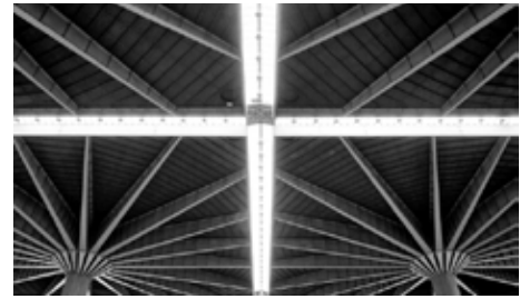
Fig. 5: Las estructuras fungiformes surgen de la repetición de una unidad autorportante
