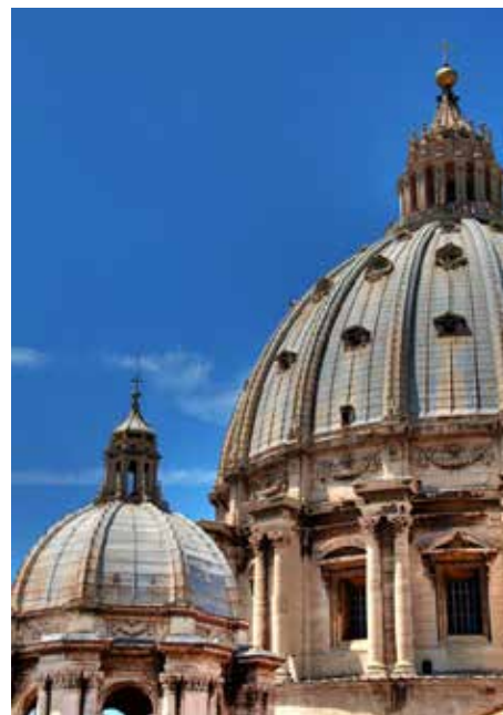
Fig. 4: La cúpula expresa un comportamiento estructural lógico para la piedra. Miguel Ángel reforzó la cúpula con llaves de hierro para que resistiesen los sillares, ahí comienza la "mentira"
