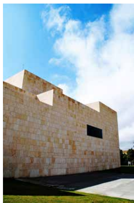
Fig. 4: La estructura y el volúmen final coinciden
