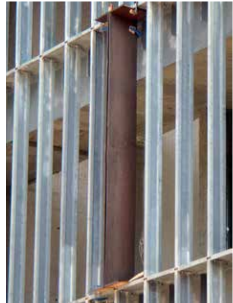
Fig. 8: Los perfiles se revisten con una chapa de bronce para aumentar la esbeltez
