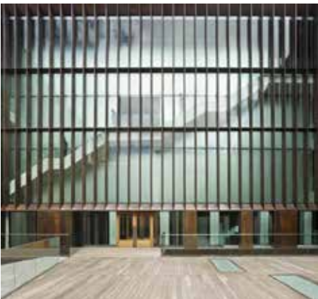
Fig. 3: En la fachada no existe ningún tipo de jerarquía estructural
