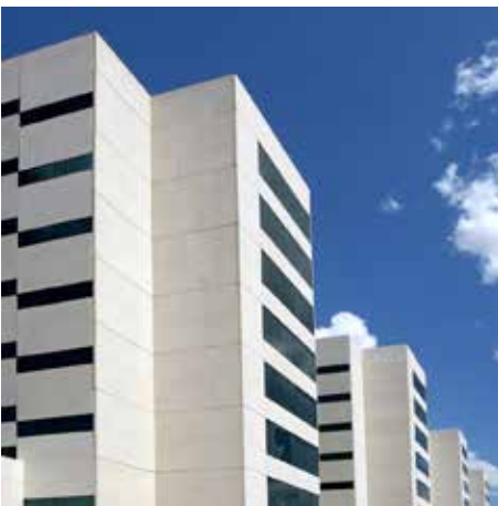
Fig. 14: Los paneles GRC son un buen ejemplo del hormigón prefabricado, confiriendo un caracter totalmente liso al hormigón armado
