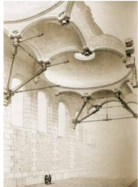
Fig. 16: Soportes metálicos soportan cúpulas de piedra
