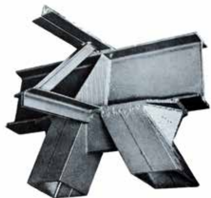
Fig. 23: Enlace por soldadura
