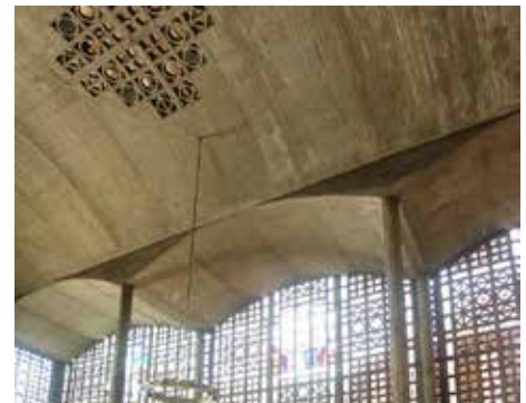
Fig. 24: La escasez de ornamento, dejando el hormigón visto, nos permite percibir perfectamente la expresividad de su estructura
