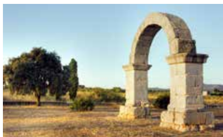
Fig. 6: La expresión horizontal de la piedra es el arco o la cúpula, no una viga plana
