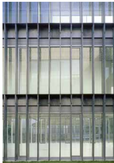
Fig. 1: El muro descompuesto proporciona una buena protección solar a norte, pero no a sur
