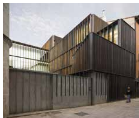
Fig. 2: El contraste se establece entre lo macizo del cerramiento exterior y lo permeable y ligero del interior
