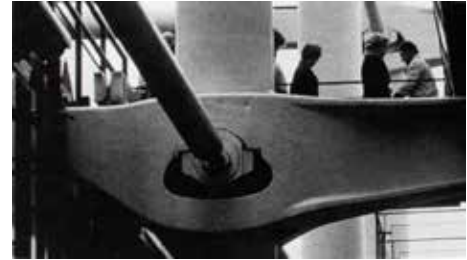
Fig. 21: Gerbeta de fundición. Observando a la gente se ve claramente la escala de la pieza
