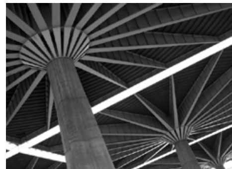
Fig. 31: Estructura fungiforme en la que vuelve a expresar las necesidades resistentes
