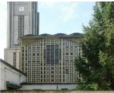
Fig. 22: Las fachadas se desmaterializan permitiendo la apertura de un gran número de huecos
