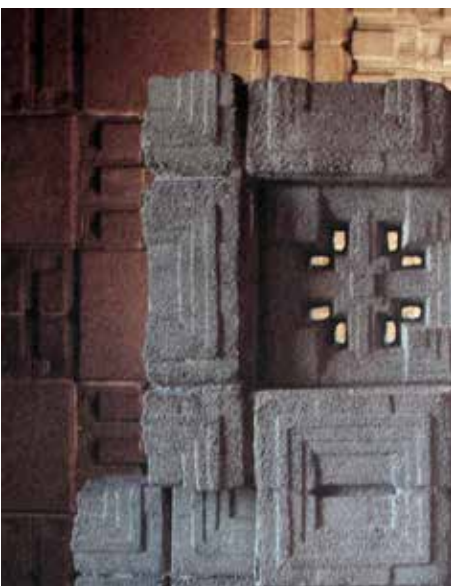
Fig. 8: Bloques de cemento "textiles" que Wright empleó en un buen número de sus edificaciones
