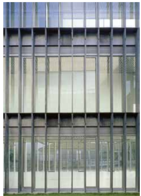
Fig. 12, 13 y 14 : El oscuro existente entre las dos pletinas aumenta la sensación de esbeltez de la estructura
