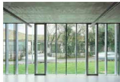
Fig. 4: El espesor de la estructura es menor que el de la carpintería, por lo que nos podemos hacer una idea de la esbeltez de las piezas, que apenas se perciben
