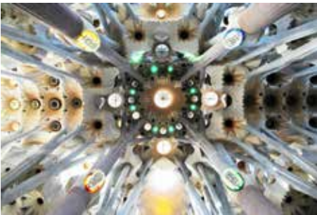
Fig. 21: Al llegar a cierta altura los pilares se ramifican para recoger todos los empujes sin la necesidad de contrafuertes o arborantes
