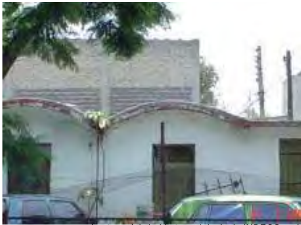
Imatges dels habitatge originals de INDECO amb volta catalana
