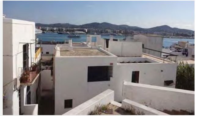
61.1. Vista de los departamentos colindantes a la casa Broner. Fotografía realizados por la autora de la tesina.
