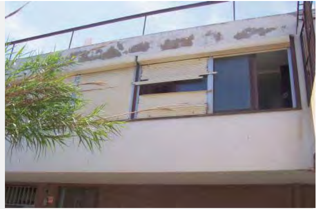
65.1. Fachada sur-este, antes de la rehabilitación.
