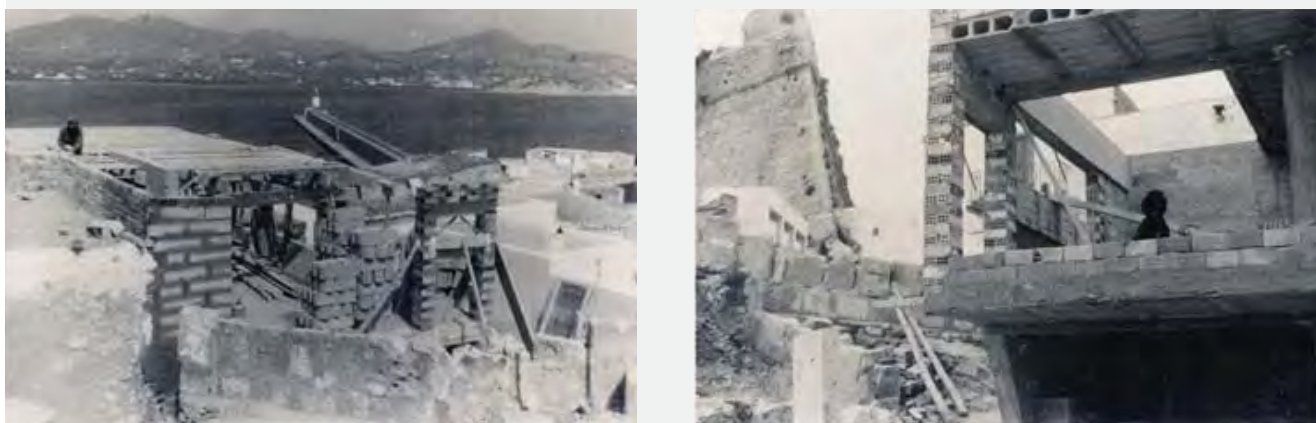
64. Fotografías del proceso constructivo de la casa Broner. Obtenidos del Archivo Broner del COAIB.
