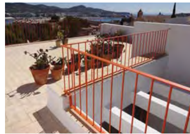
96. Baranda incorporada, estado actual, rehabilitada .
