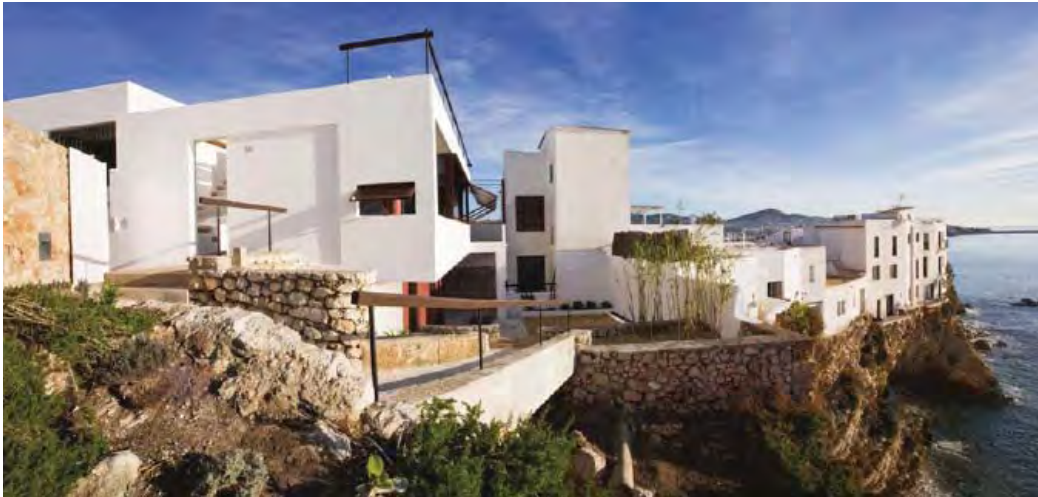
29. Emplazamiento de la casa Broner. Fotografía de Lourdes Grivé.
