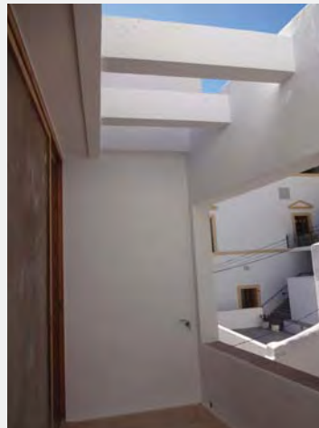
100. Terraza, planta segunda, rehabilitada.
