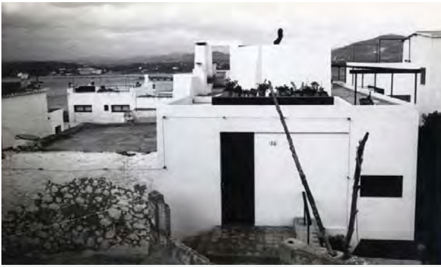
61. Vista de los departamentos colindantes a la casa Broner. Fotografía realizados por la autora de la tesina.
