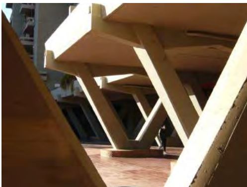
Fig. 134. Pilars en V a les plantes baixes dels blocs alts
