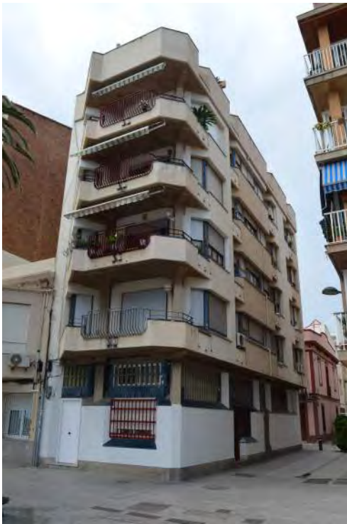
Fig. 49. Edifici a la Rambla (J. A. Padrós Galera 1967)
