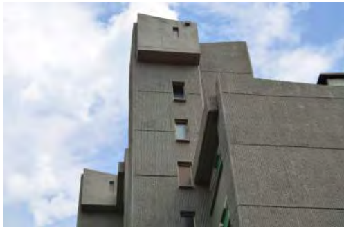
Fig. 104. Remat de les caixes d'escala i ascensors
