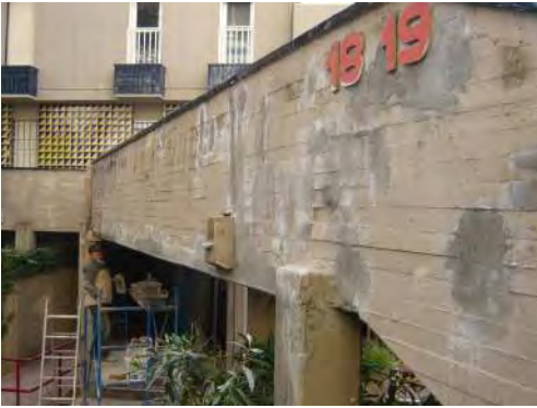
Fig. 153. Reparació de passarel·la
