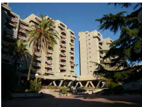
Fig. 135. Vista dels blocs 2 i 3 des de la plaça
