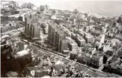
Fig. 103. Vista aèria de l'obra
