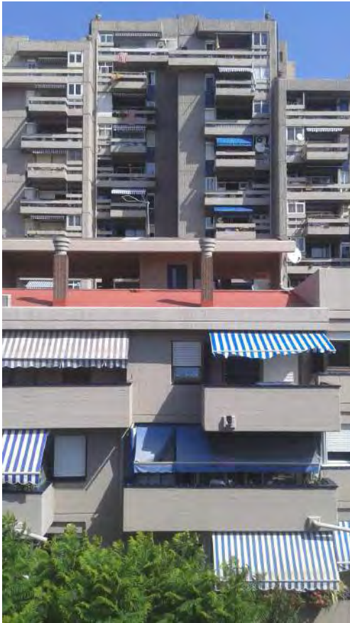
Fig. 96. Imatge des d'un dels rentadors dels blocs baixos
