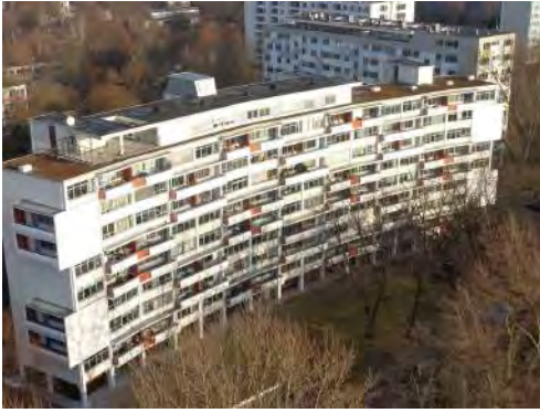
Fig. 22. Edifici de Walter Gropius
