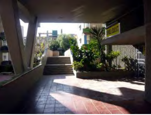
Fig. 93. Accès a passarel·la 2
