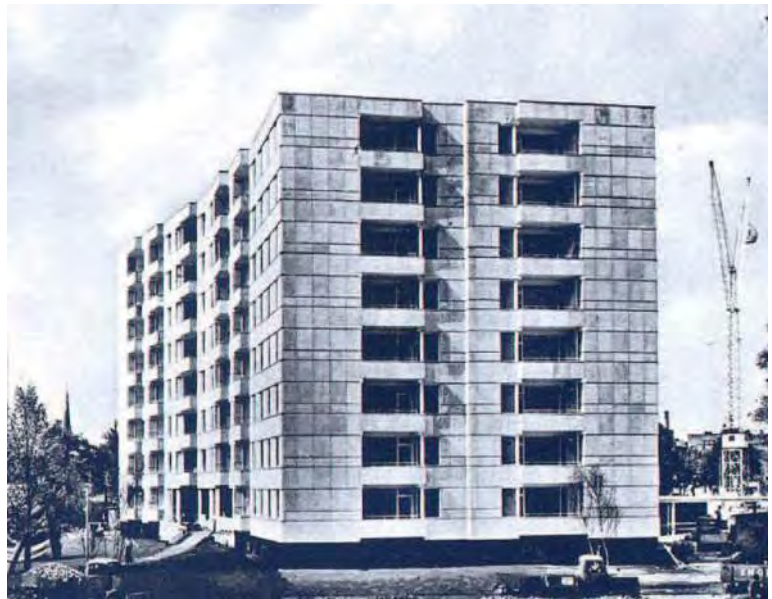
Fig. 112. Vista edifici d'Alvar Aalto a Hansaviertel
