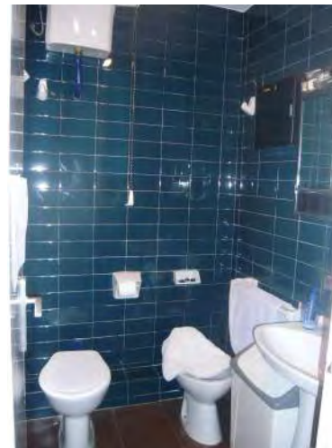
Fig. 140. Bany d'habitatge de blocs baixos acabat d'enrajolar posteriorment a adquirir-lo
