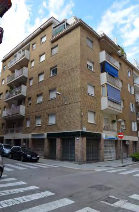
Fig. 29. Edifici carrer Tavern 34 (F.J. Barba Corsini 1952-1954)
