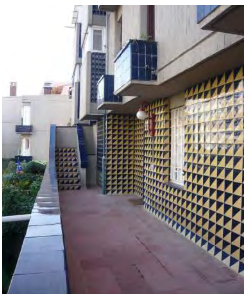
Fig. 105. Acabats ceràmics a passarel·les i accessos
