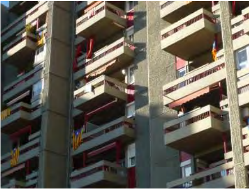
Fig. 101. Imatge dels balcons dels blocs alts
