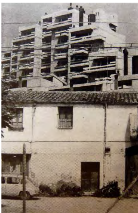
Fig. 63. Fotografia de la construcció i en primer terme cases de l'entorn
