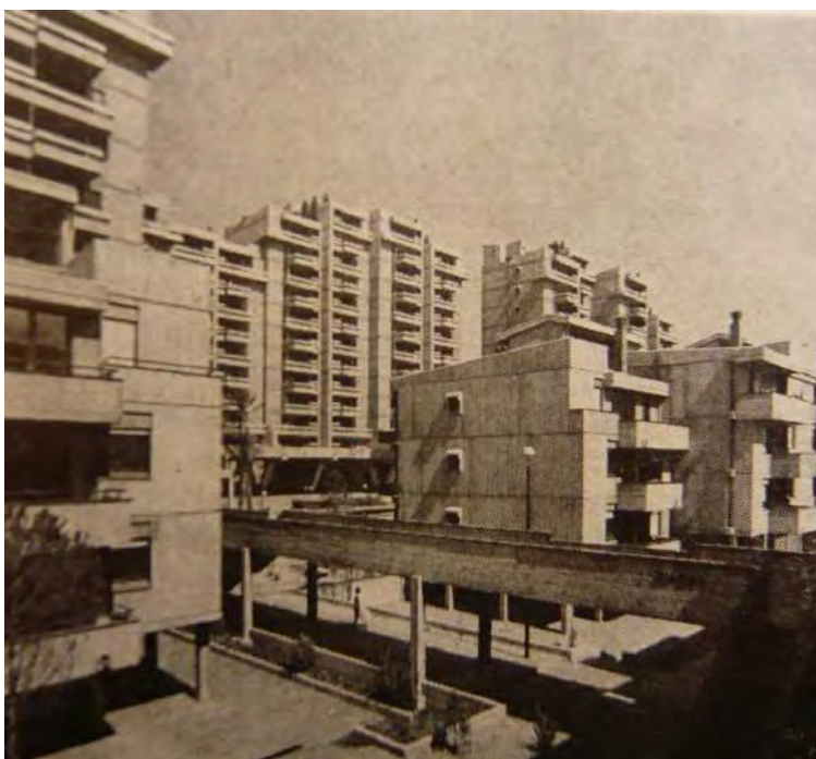
Fig. 66. Imatge interior del conjunt un cop finalitzada l'obra
