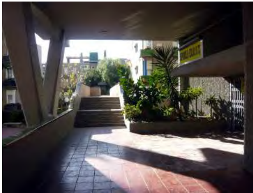
Fig. 69. Accés a una de les passarel·les
