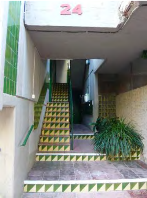
Fig. 161. Accés a escala de blocs baixos
