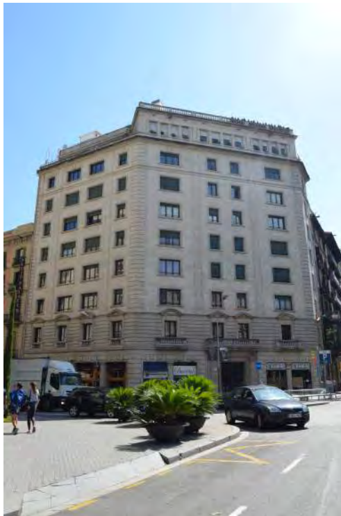
Fig. 31. Edifici Av. Gran Via 662 (F.J. Barba Corsini 1946-1948)
