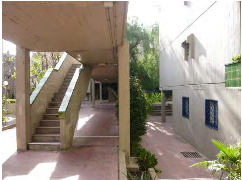
Fig. 107. Espai sota passarel·la
