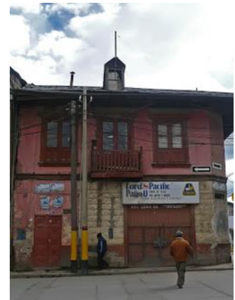
2.39 Antigua Casona de uso vivienda y comercio en el centro de Chaupimarca. Fuente: www.google.com
