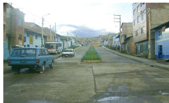
3.61 Infraestructura Vial existente en la Ciudad de Cerro de Pasco, Calles estrechas en el distrito de Chaupimarca. Fuente: www.google.com
