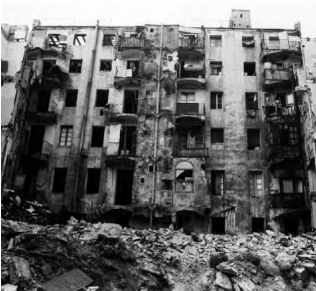
Figura 5.12: Uno de los derribos de edificios de vecinos que se hicieron en el barrio en los años 90. Fuente: Fotografía de Josep Losada
