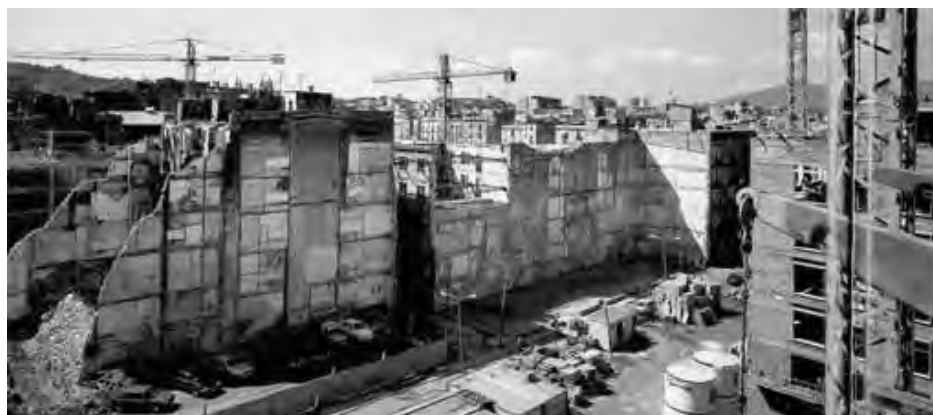
Figura 5.11: Demolición limitrofe a la Rambla del Raval. Fuente: "La costruzione politica e architettonica del centro storico di barcellona 1979 2011" Tesis Doctoral de Alessandro Scarnato.
