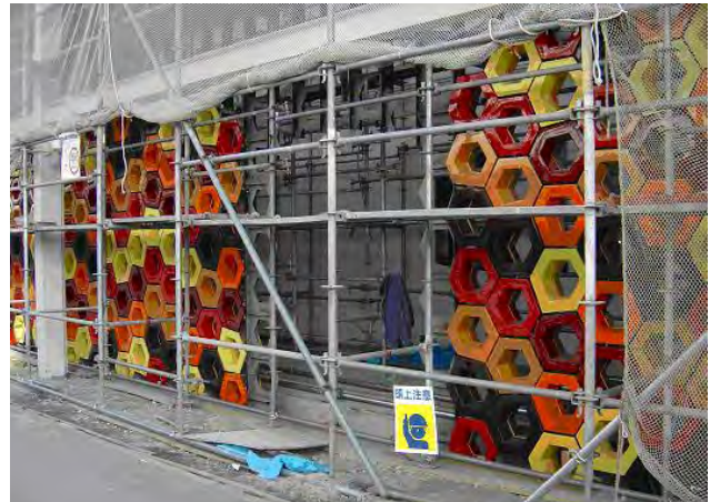
Ilustración 66 Instalación de piezas cerámicas. (Cumella T. , 2016)
