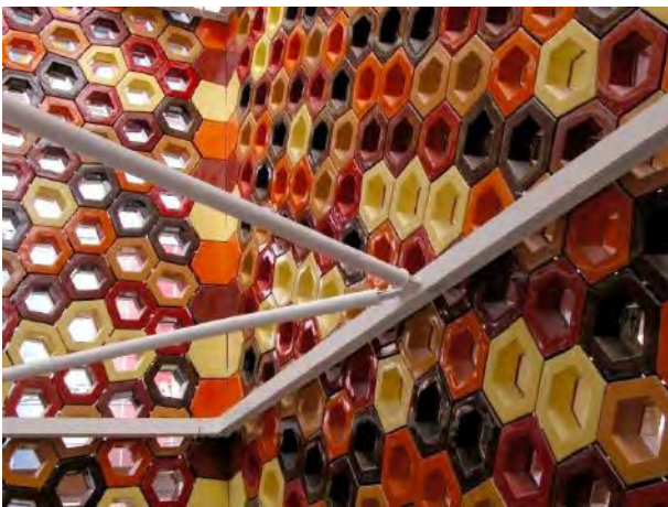
Ilustración 39 Fotografía esquina desde el interior.
