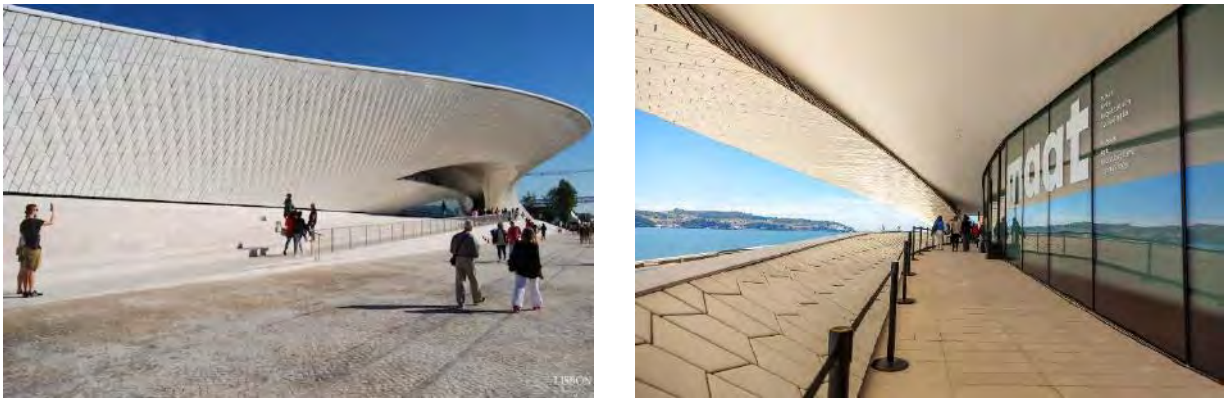
Ilustración 79 MAAT Fachada y Ventana. (LisbonLux, s.f.) y (Matos)
