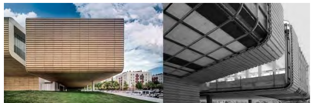
Ilustración 19 Ejemplo de sistema anclado. Escuela de Magisterio. Ramón Fernández Alonso. Granada España 2012 (Alonso, s.f.)
