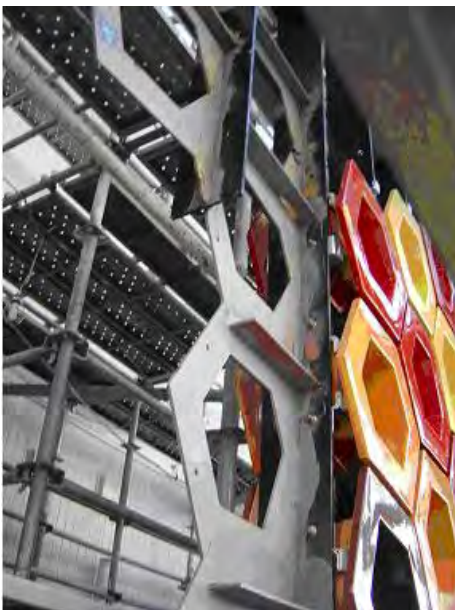
Ilustración 65 Estructura metálica en accesos. (Cumella T. , 2016)
