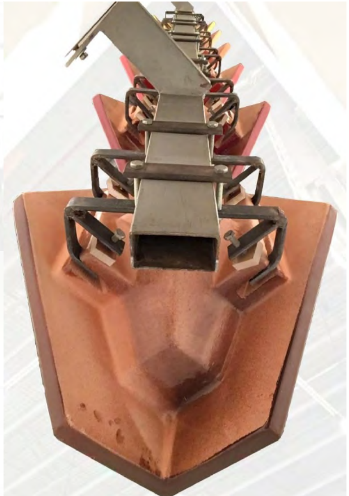
Ilustración 60 Sujeción de las piezas de esquina a través de las ranuras y los anclajes puntuales sobre las mismas. Exposición De Obra. Cerámica Aplicada a la arquitectura. Museo del Diseño de Barcelona. Fotografía Daniela Eslava.
