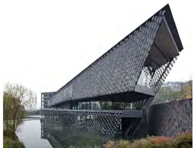
Ilustración 20 Ejemplo de fachada cerámica con sistema colgante con cable de acero inoxidable. Xinjin Zhi Museum. Kengo Kuma. Chengdu, China, 2013 (Associates, s.f.)
