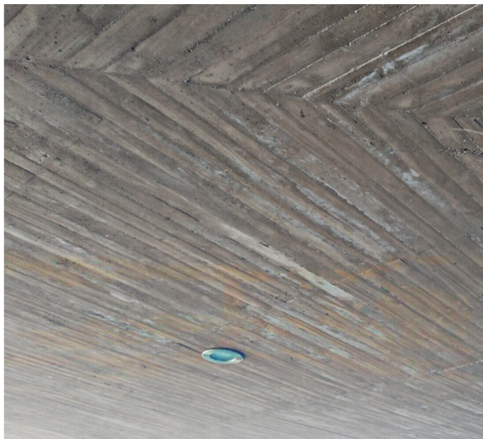
Cubierta de hormigón con textura del encofrado de madera, Mirador de la granja de Toledo
