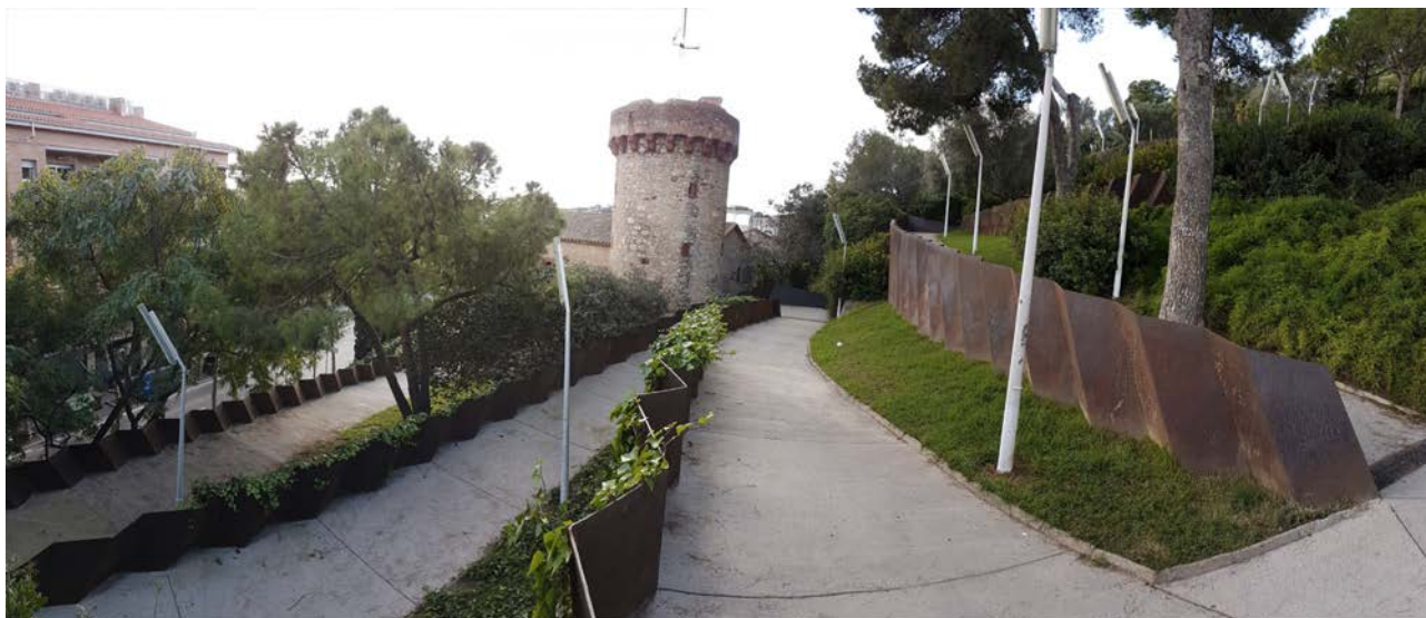
Planos metálicos en relación a las preexistencias, adaptándose a la topografía
