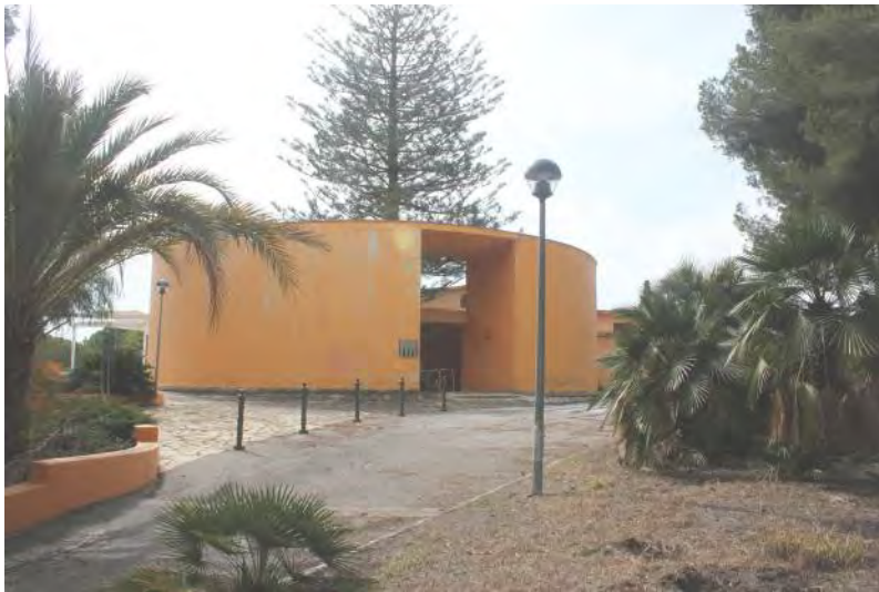
Foto A.04 Vista façana posterior edifici Recepció Font: autor.
