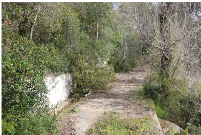
Foto A.18 Estat actual d'un dels camins de la zona alta del Residencial Font: autor.
