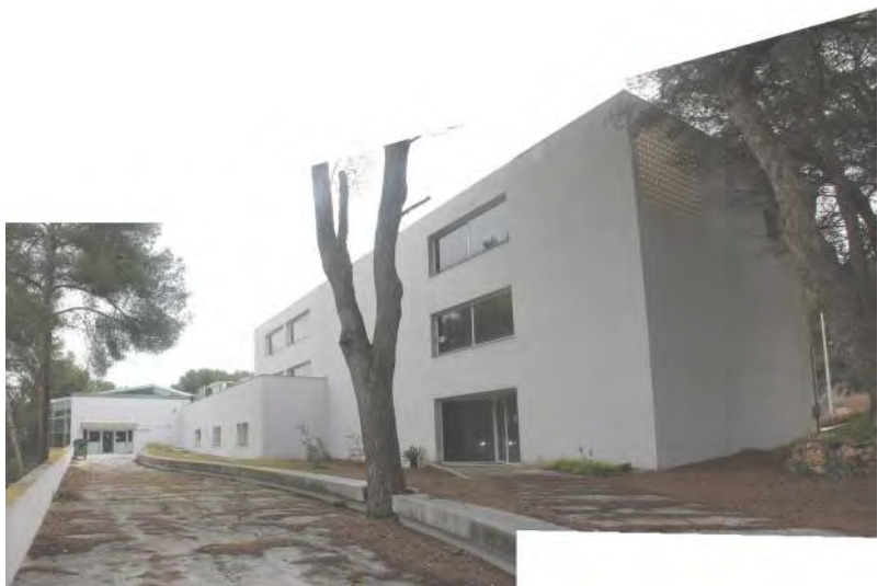
Foto A.03 Vista façana posterior edifici Menjador Font: autor.
