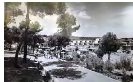
Figura 5.06 Vista de la Ciutat Residencial de Tarragona des d'un dels seus camins. Font: Foto Raymond, 1957. (AHT)
