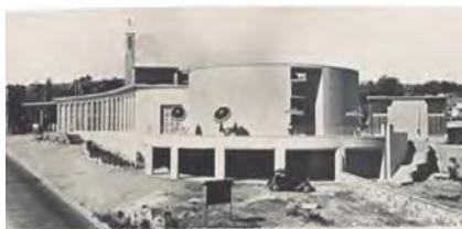
Figura 5.18 Vista bolera i de fons zona esportiva Font: Foto Raymond, 1957. (AHT)
