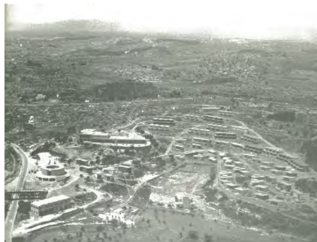
Figura 5.19 Vista aèria CRT, 1957 Font: Hogar y Arquitectura núm. 13
