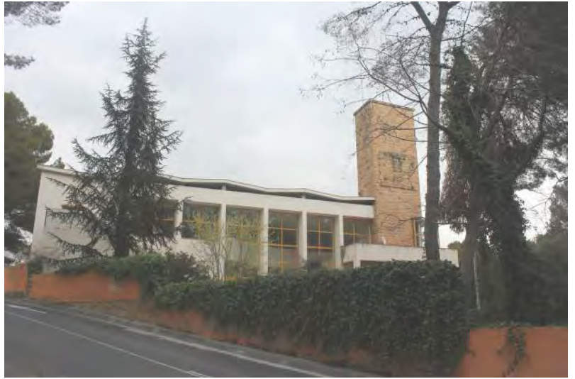
Foto A.01 Vista exterior edifici Menjador Font: autor.
