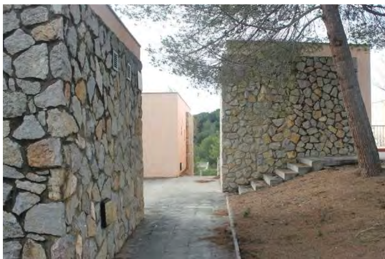
Foto A.12 Vista exterior de l'accés als mòduls Residencials Font: autor.
