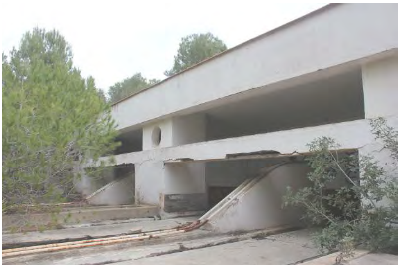
Foto A.15 Vista posterior de la zona de bolera Font: autor.
