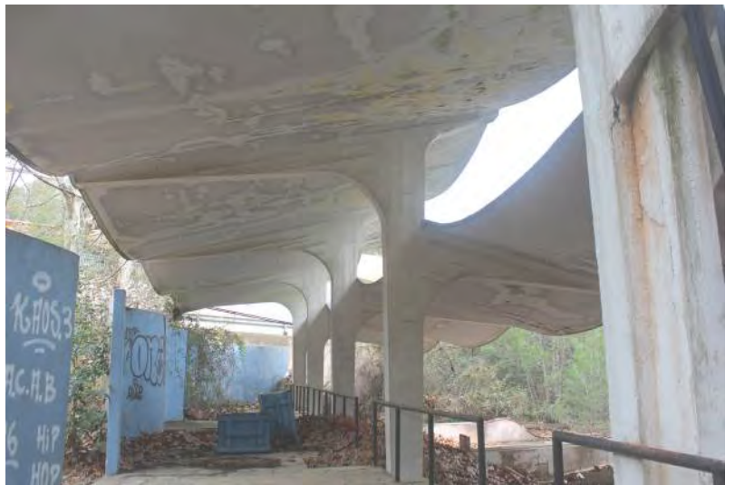
Foto A.14 Vista interior de la pèrgola de la bolera Font: autor.
