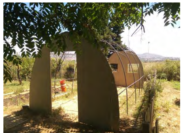
Figura 12. Instal·lació dels frontals creant una unió amb l'estructura.
