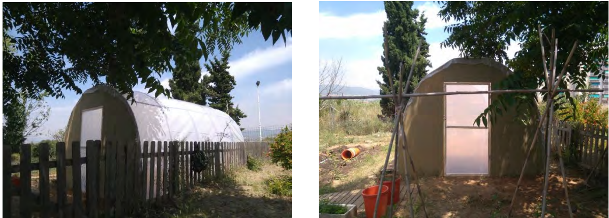
Figura 13. Vistes de l'hivernacle amb el plàstic instal·lat i porta d'accés.
