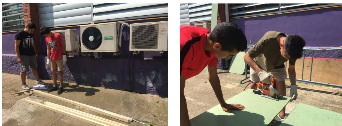
Figura 10. Planificació i execució de talls amb diferents eines.
