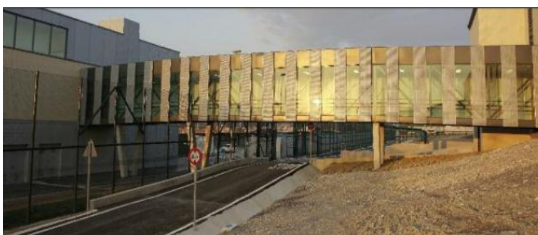
Imagen 3. La pasarela. Como puente de conexión entre el edificio de Control de Accesos y el edificio de las Oficinas y el Cuerpo de Guardia, está sobre elevada por encima de los diversos perímetros de seguridad.
