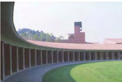
Fig 146. Caves Raventós i Blanc. Bach i Mora. 1989. El muro cerámico se fragmenta y se convierte en discontinuo.
