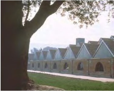
Fig 93. Nave de almacen y embotellado. Vista exterior
