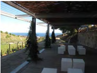
Fig 102. 2011. Centro de recepción y degustación Alta Alella
