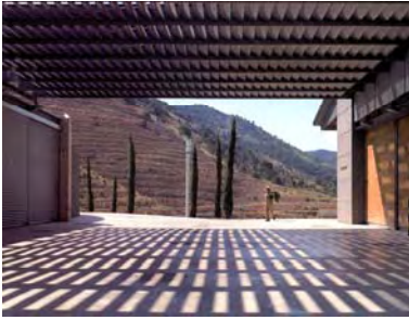
Fig 8. Palio de acceso bodega Ferrer Bobet. Priorat. Arq. Espinet i Ubach.
