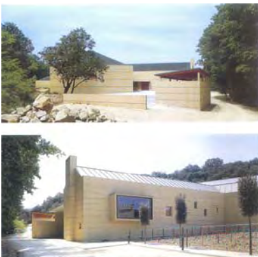
Fig 40. El muro se encaja en el terreno
