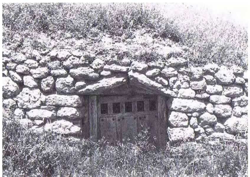
Fig 15. Acceso a bodega. Sostreagudo. Burgos
