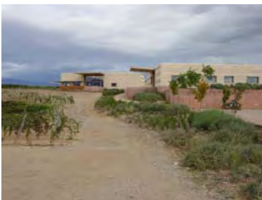
Fig 36. Aproximación a los pabellones Acceso.
