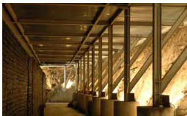
Fig 140. (CV) Cavas enterradas. El terreno aparece como una fachada interior
