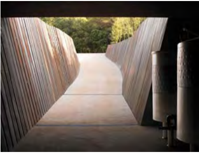
Fig 145. Celler Brugarol. RCR. 2007. Yuxtaposición de elementos discontinuos generando un muro continuo
